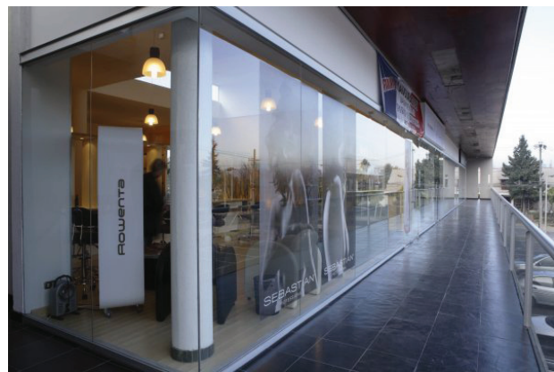
Ilustración n°64. Tienda tipo en Strip Center. Fuente: Imágenes Google.
