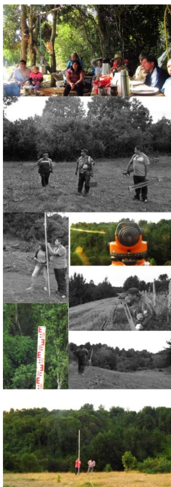
Ilustración 22_ Fotografías levantamiento topográfico terreno. Elaboración propia
