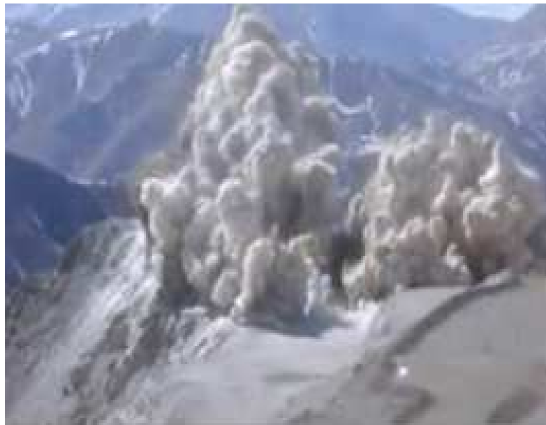
Figura 19 Voladura en Pascua Lama
