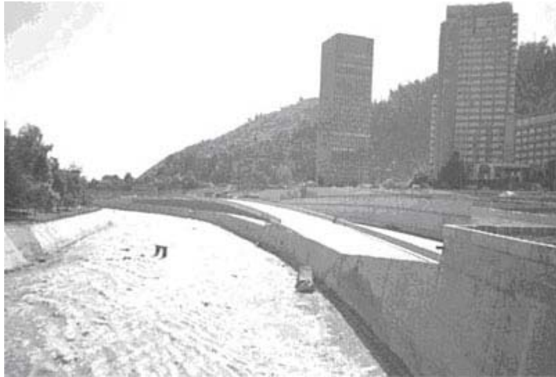
Fig.12.- La Autopista Costanera Norte, en Providencia, frente a hotel internacional, no evidencia tratamiento paisajístico en la ocupación del espacio cauce del río en todo su recorrido. 2007.
