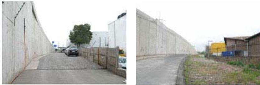
Figs. 13. y 14.- Autopista Costanera Norte, en Renca, no sólo no evidencia tratamiento paisajístico en su paso por ciertos barrios junto al río, sino que impone un grosero muro, que impide hasta la visión del río. 2007.
