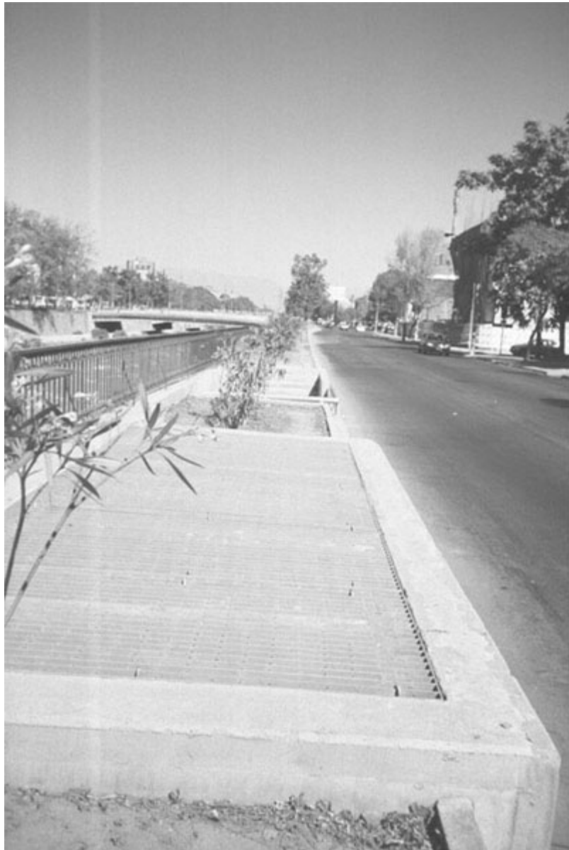
Fig.21.- Borde del río en la comuna de Recoleta, impracticable como acera, producto del diseño resultante del paso de la Autopista Costanera Norte y sus necesidades de ventilación.
