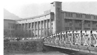
Fig.9. Edificio de la Facultad de Derecho de la Universidad de Chile, obra del Arqto. Premio Nacional de Arquitectura J. Martínez Gutiérrez, Escuela Movimiento Moderno, 1938. Fte.: En archivo del Arqto. Dr. M. Cuadra. K., de su autoría.
