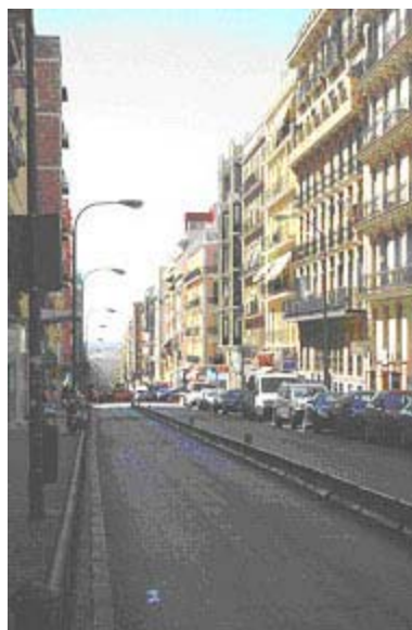
Fig.6. Barrio de Argüelles, calle de Fernández de los Ríos, vista hacia el Parque del Oeste.
