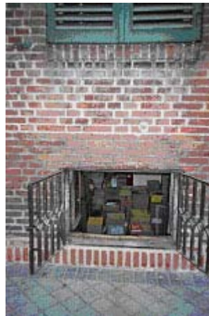
Fig. 32. Ventana para ventilación de recinto soterrado ocupado como bodega. Fachada en calle de Hilarión Eslava. Foto. M.I.P., 2006 ©
