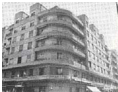
Fig. 4. Anexo 2. Conjunto de viviendas. Situación: calle de Fernando el católico, 2, 4 y 6; c/v Escosura 2 y 4; c/v Magallanes. Autor: Manuel López Mora. Fecha: 1934. Fte.: COAM, 1983, op.cit.
