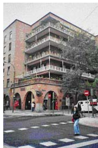
Fig. 8. Vista parcial de la Casa de Las Flores, en la esquina de Hilarión Eslava y Rodríguez San Pedro, próxima a la calle de la Princesa. Foto. M.I.P., 2006 ©
