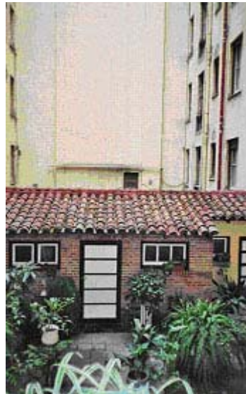
Fig. 41. Vista de uno de los patios interiores de la Casa de las Flores. Estos patios y construcciones menores fueron diseñados con lavaderos comunes que ya no se usan. Foto. M.I.P., 2006 ©
