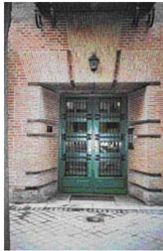
Fig. 28. Detalle de acceso residencial por calle de Hilarión Eslava. Foto. M.I.P., 2006 ©
