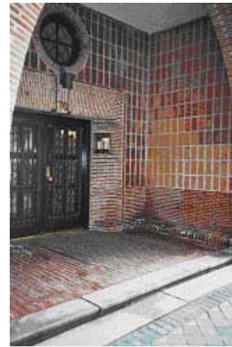
Fig. 29. Detalle de acceso residencial a través de arco, por calle de Rodríguez San Pedro. Foto. M.I.P., 2006 ©
