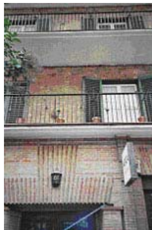
Fig. 21. Detalle de fachada a calle de Meléndez Valdés. Foto: M.I. Pavez R., 2006 ©
