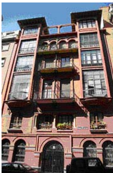
Fig.2 Anexo 1.- Edificio de viviendas -arquitectura regionalista- ubicado en la calle Fernández de los Ríos Nº96. Autor: (s.d.c.), año 1920. Edificio entre medianerías para vivienda de renta media, con disposición simétrica, sobre parcela irregular y con fachadas a la calle y al patio de la manzana, realizándose dos viviendas por planta. Arquitectura regionalista característica de los años 1920, de la que hubo gran abundancia en el barrio
