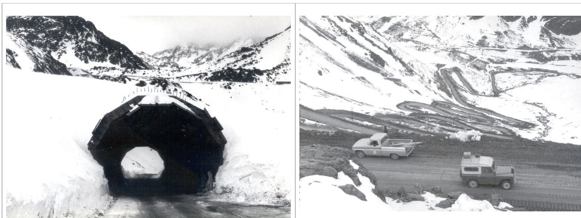
Figs. 23-24. Diversas vistas de la obra en construcción del Camino Internacional Valparaíso – Los Andes – Mendoza.
