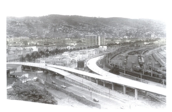
Fig. 21. Tramo inicial de la autopista de Valparaíso a Viña del Mar construido. Vista al sur, sobre la bifurcación de la autopista en Barón, para tomar la Avda. Argentina, y la dirección al Puerto. Fte.: Foto de G. González G., s/f., inédita en Archivo RR.PP., M.O.P., 1998.
