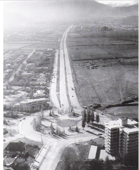
Fig.40. Avda. Kennedy en construcción, a la altura de A. Vespucio, (vista al oriente).
