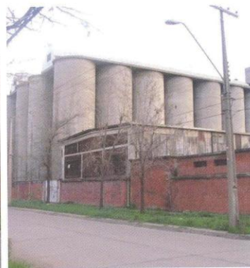
Ex Empresa de Comercio Agrícola (demolida)
