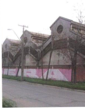
Ex Bodegas y Silos, Empresa de Comercio Agrícola (demolida), ejemplo de Patrimonio Industrial
