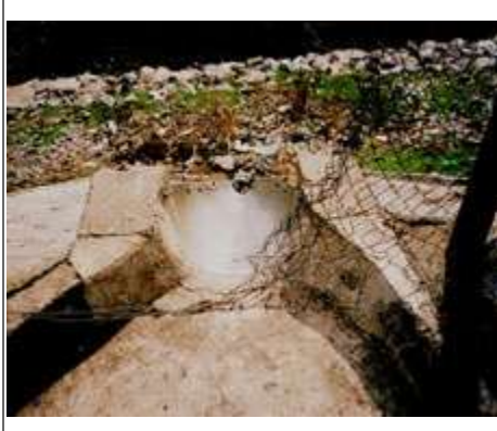
Fig. 28.- Vertedero de aguas de escorrentía contaminadas desde el ámbito urbano, al río Mapocho, 2009.
