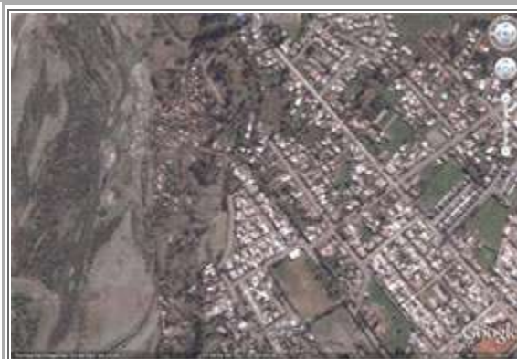
Fig. 21.- Pequeño tramo norte de la antigua costanera de Talagante, hoy construido. Fte. Google Earth, 2009.
