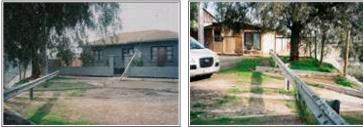
Figs. 16 y 17.- Viviendas sobre la banda correspondiente a la antigua costanera de 1945, en 2009, y barrera de protección de vehículos.
