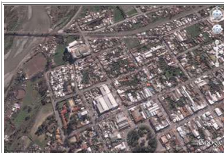
Fig. 15.- Viviendas sobre la banda que correspondía en la planificación de 1945 a la Av. Costanera. Vista desde calle Eyzaguirre (Plaza de Armas), perpendicular al río sin solución de término. Fte. : Google Earth 2009.
