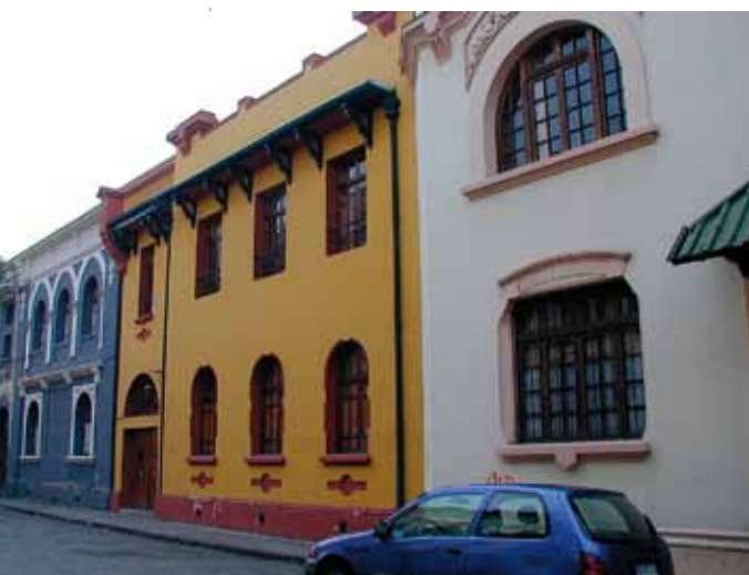
Inmueble rehabilitado en Pasaje Lucrecia Valdez, Barrio Yungay, Santiago.
