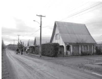
Imagen 3: Vivienda en Villorrio Prudencio Lozano. Curicó.
