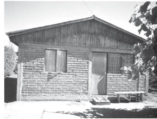
Imagen 10: Vivienda en Villorrio Cordillera. Localidad de Potrero Grande. Curicó. Esta tipología es una de las más básicas encontradas en los Villorrios, y regularmente conservada y mantenida por sus habitantes. Son de albañilería reforzada sin revestimientos exteriores y con terminaciones de regular calidad. Es una tipología común en periferias urbanas de la gran mayoría de ciudades chilenas.
