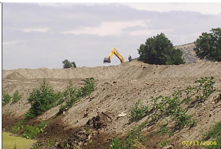
Figura 3. Disposición final del suelo. En primer plano, el terraplén de material edáfico con abundante microrelieve y nivel freático a escasa profundidad. Al fondo, fajas de suelo sin desparramar.
