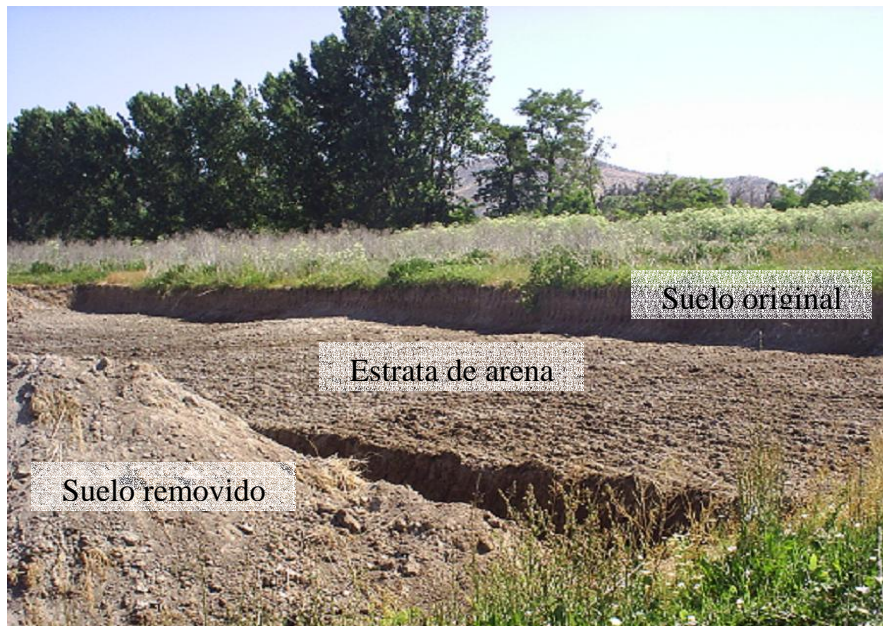
Figura 2. Terraplenes generados luego de la remoción de horizontes superficiales, dejando expuesto el material a extraer.
