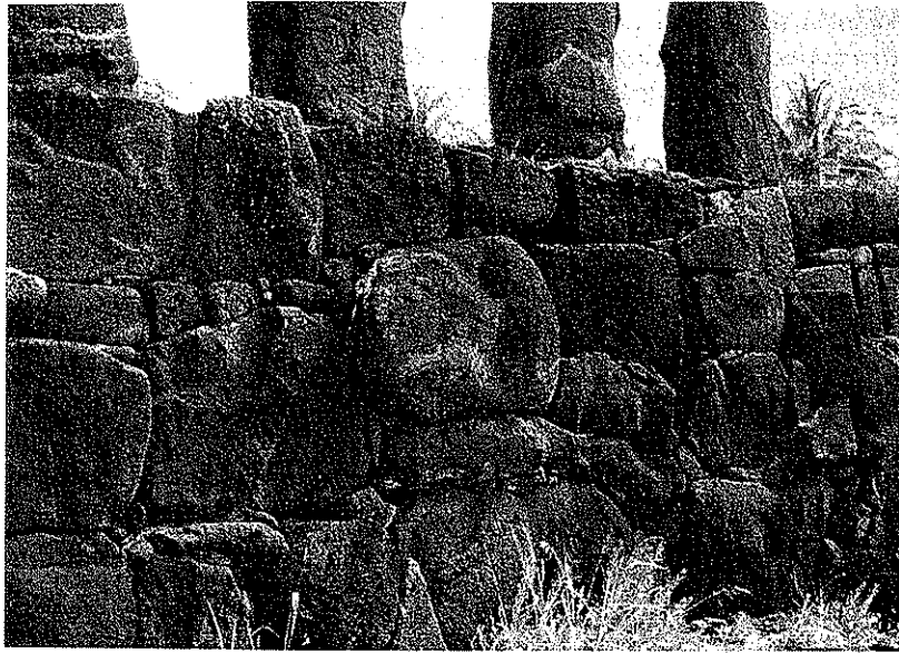
Figura 8.2. Muro posterior de ahu Nau Nau en 1991. Foto archivo de los autores.
