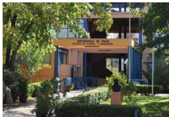
1. Edificio actual de la Facultad de Filosofía y Humanidades, originalmente construido para albergar a la Biblioteca Central de la Universidad de Chile.
