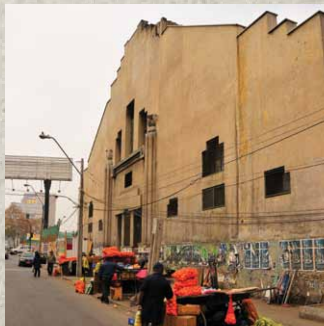
1. La mayoría de los vecinos del recinto no saben que este imponente edificio alberga una piscina. La cara que da a la calle Bellavista cobija las calderas custodiadas fielmente, desde 1971, por don Hernán Rivera, conocido como "el calderero" y memoria viva de nuestra historia universitaria.
