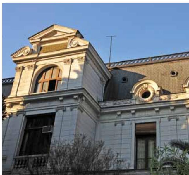
1. Edificio de la antigua Escuela de Química y Farmacia, en Vicuña Mackenna. Don Armando Soto Parada, su directo, consiguió en el año 1925 la adquisición y la adaptación del edificio, el que luego de su uso residencial, había sido ocupado por una bodega de vinos. Quizás por ello, desde 1923 era un lugar de encuentros universitarios. En sus instalaciones también se encuentran los laboratorios del IDIEF y CEDETEF, prestadores de servicios para la industria alimenticia y farmacéutica.
