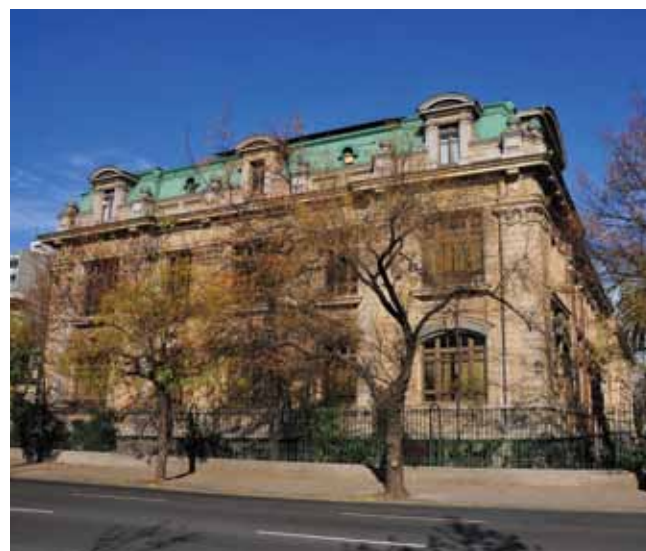
1. En la Guía de Arquitectura de Santiago de Chile , se dice: "es notable cómo su escala se adecua al sector al estructurar la manzana en su borde hacia Avda. Beauchef y parte del borde norte (Avda. Blanco Encalada)". En marzo de 1985 el edificio original fue severamente dañado por el terremoto. Las obras de reconstrucción y remodelación se iniciaron en 1993, y se inauguraron en 1997.
