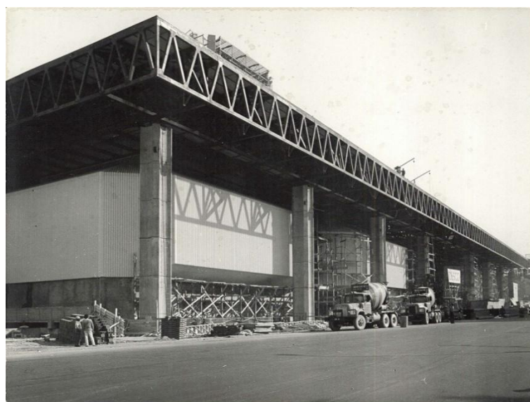
Ilustración XL – XLI: Vista desde la calle José Ramón Gutiérrez durante la construcción del conjunto UNCTAD III (AUCA Nº22, p.63). Imagen VI: Proceso de montaje de la placa con las columnas. Los capiteles triangulares son las piezas que unen placa y columnas. Se puede apreciar también el detalle del capitel que une el pilar con la viga.
