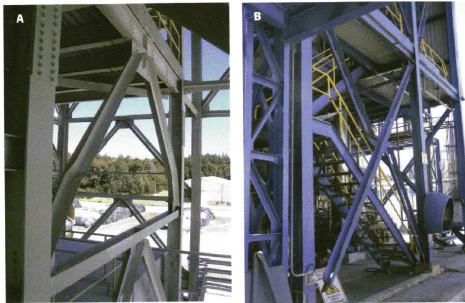
Figura 1: Imágenes extraídas del libro Mw=8.8 Terremoto en Chile. Pandeo global de diagonales. (A) Producto del pandeo local de alas. (B) Pandeo torsional
