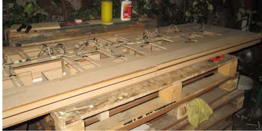
Fig. 43: Incorporación de circuito eléctrico Imagen de registro personal.
