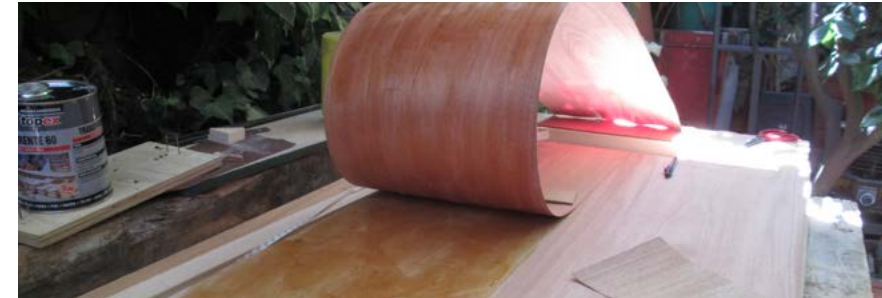
Fig. 40: Enchape de cara exterior. Imagen de registro personal.
