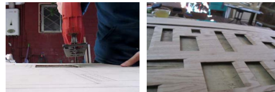
Fig. 33: Corte Fig. 34: Cara interior enchapada. Imágenes de registro personal.
