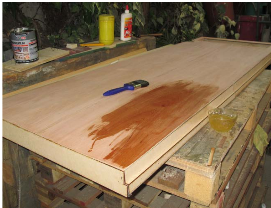
Fig. 44: Aplicación de sellante de madera. Imagen de registro personal.
