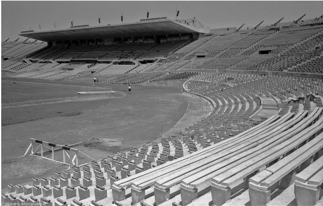
46. Remodelación del estadio en 1960, se observa la implementación de las nuevas graderías sobre lo que fue el velódromo (aún sin tablonés) y la construcción de la cornisa superior de graderías
