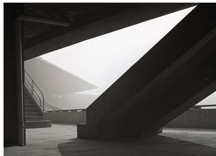
39: Marquesina en construcción
