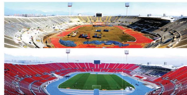
55. Estadio durante la remodelación y después
