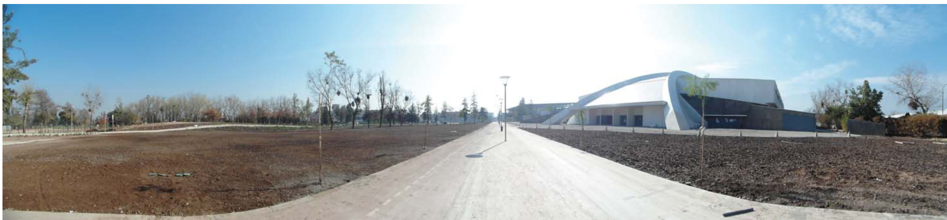
66. Parque actualmente en construcción
