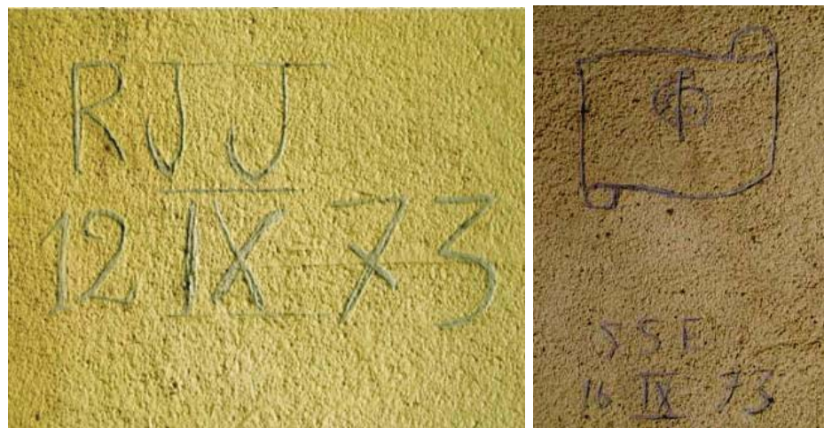
23. Huellas en los muros de la Escotilla 8
