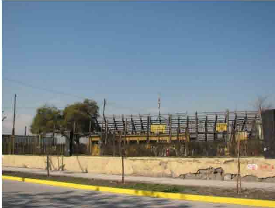
Imagen 183: Estadio de Ferroviario . Fuente: Fotografía Departamento de Urbanismo, agosto 2008.
