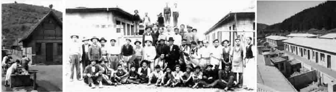
Imagen 102 Población La Rana. Imagen 103: Construcción de Pabellones hacia 1938. Imagen 104: Pabellones de trabajadores. Fuente: http://www.memoriabellavista.cl/03%20iNVESTIGACION/Nacimiento%20comunidad%20Bellavista.html
