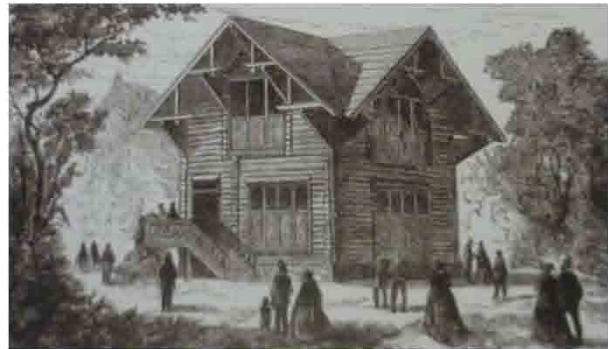
Imagen 14: Casa prefabricada de madera de Stanislaus Ferrand. Fuente: Ageorges Sylvain, "Sur la traces des Expositions Universelles 1855 Paris 1937, á la recherche des pavillons et des monuments oubliés", Parigramme, Paris, 2006.
