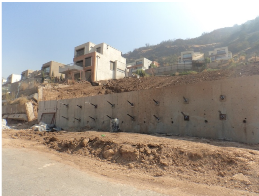
Figura 4.35. Muro de hormigón como obra de estabilización en la zona de estudio.
