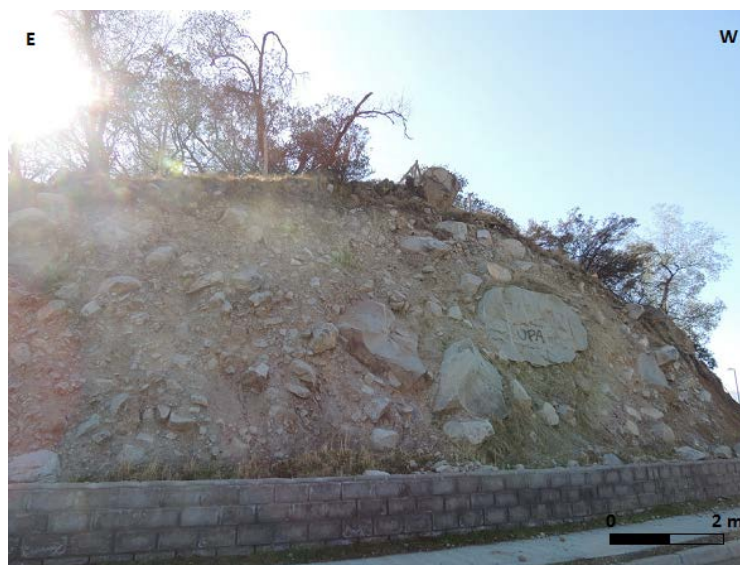
Figura 4.24. Depósito de remoción en masa antigua al oeste de la quebrada de Los Chanchos.
