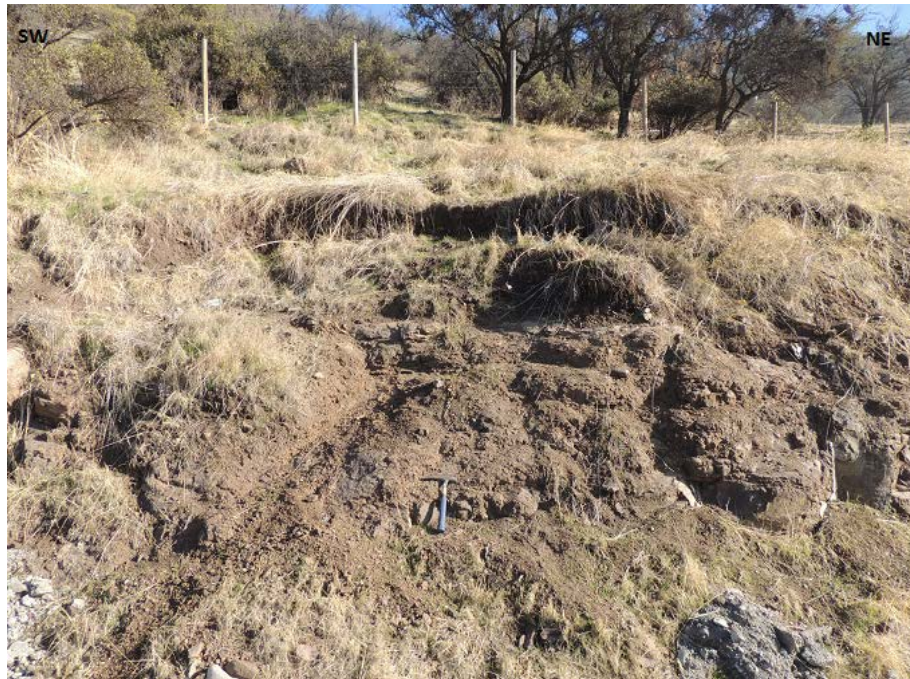
Figura 4.22. Rasgos de deslizamiento superficial de suelo en talud artificial hacia el este de la quebrada de Los Chanchos. Se observa una componente rotacional y de reptación.
