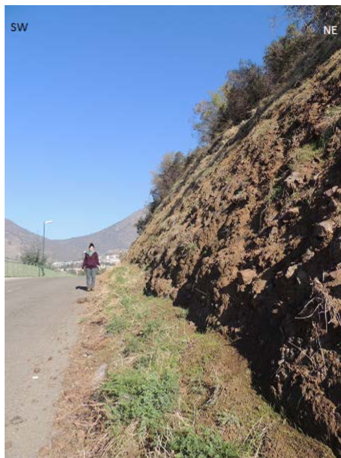
Figura 4.20. Depósitos de caída en talud artificial limitando con la zona urbana del área de estudio.
