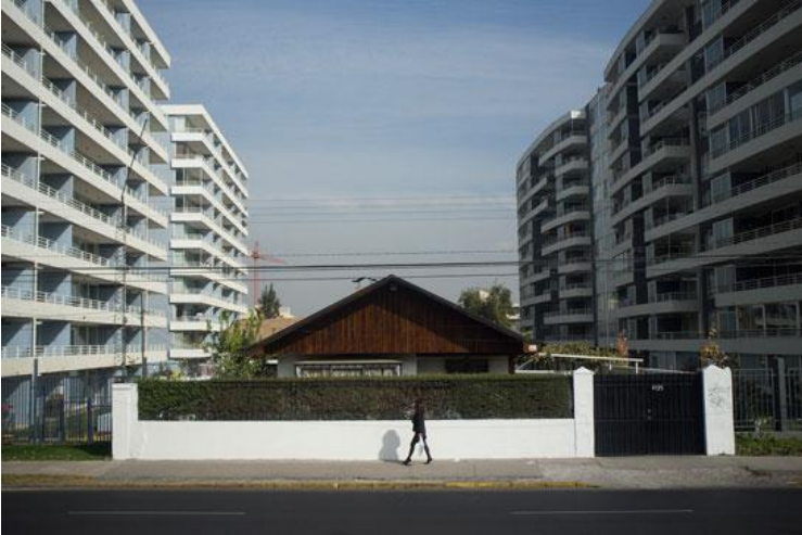
Imagen 12: Consecuencias de la construcción en altura
