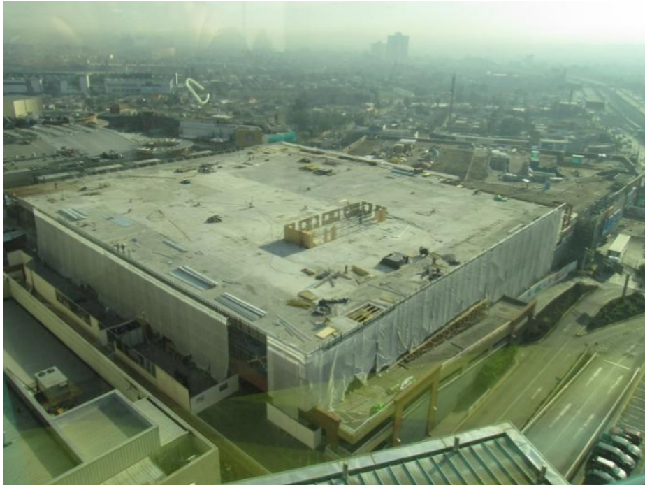
Figura 1.2: Proyecto HOMOY en construcción
