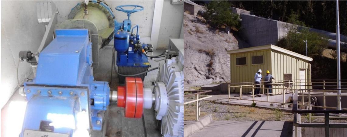
Figura 3.14: Casa de máquinas el Rincón, turbina de flujo cruzado.
