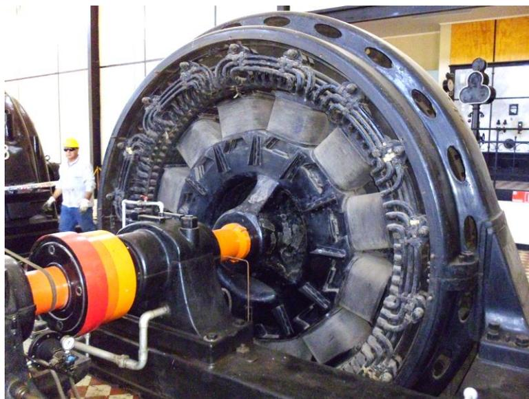
Figura 2.47: Generador síncrono Siemens de 12 polos, Central Florida 1.
