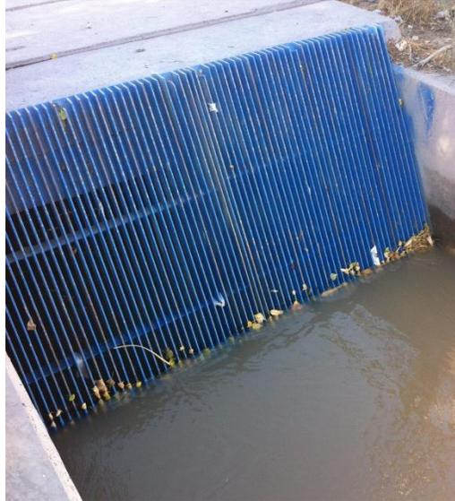
Figura 2.16: Rejilla de limpieza en cámara de carga, central Eyzaguirre.
