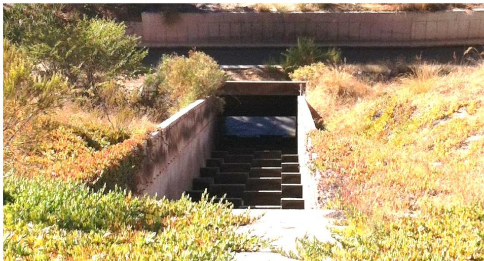
Figura 2.12: Cuenco dissipador con bloques de hormigón, central Eyzaguirre.
