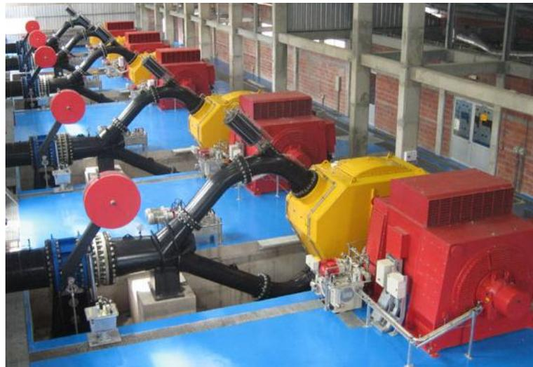
Figura 2.27: Grupo de turbinas Pelton de 2 inyectores [15].
