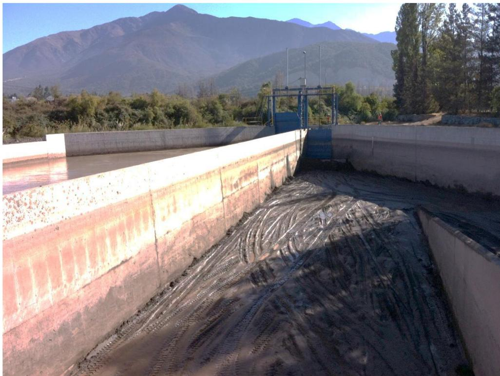
Figura 3.18: Desarenador presente en la central Eyzaguirre.
