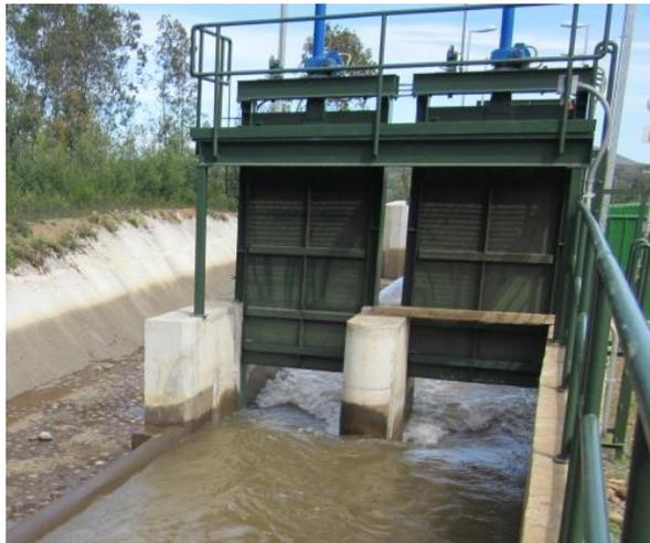
Figura 2.14: Compuertas deslizantes en cámara de carga, Central Renaco.
