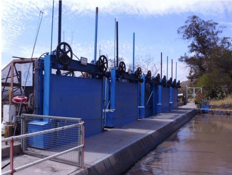
Figura 3.9: Compuertas de guillotina en cámara de carga de central Florida.
