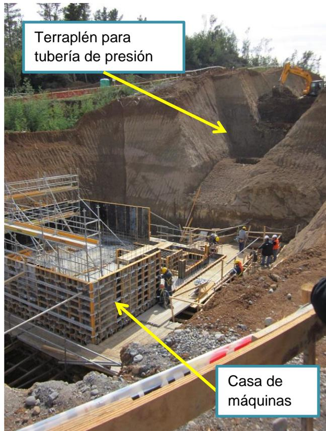
Figura 3.6: Construcción de la central Alto Renaico.
