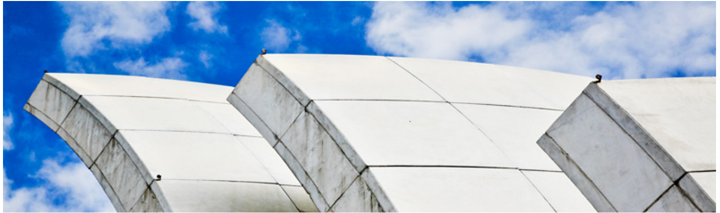
8. Richard Meier, Roma, Iglesia Dives en Misericordia , detalle del hormigón i.active utilizado por primera vez en este edificio
