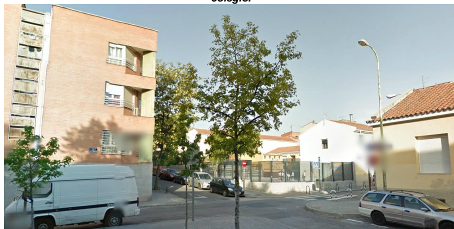
Fig.- Vista desde el poniente. A la izquierda, edificio de los comedores escolares, construido en 1951. De frente, testero de la actual residencia de religiosos. A la izquierda, nuevos bloques de vivienda pública construida en la década de los 90.
