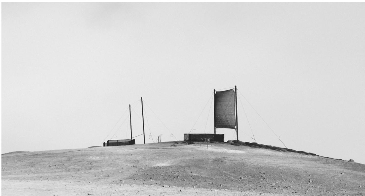
18. Atrapanieblas LFC (40 m<sup>2</sup> de malla de captación) en Alto Patache.
