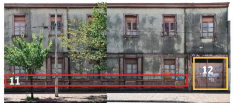
Fachada Poniente (b)
