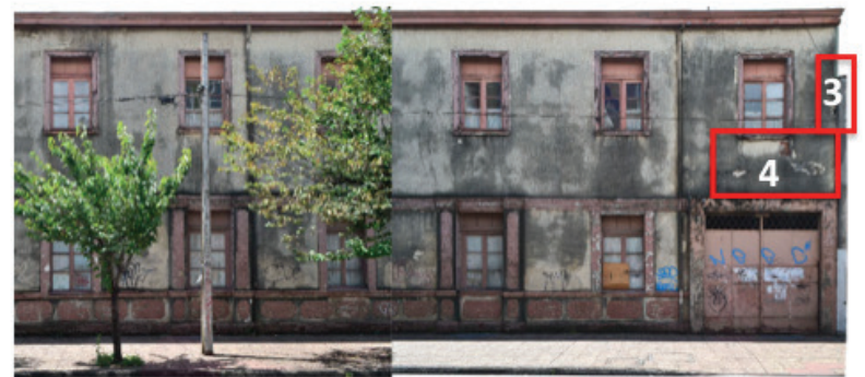
Fachada Poniente (b)
