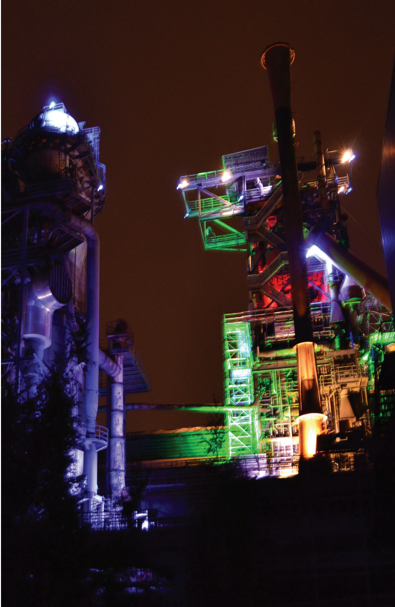
Figura 22: Estructuras iluminadas en el Landschaftspark Duisburg Nord. Fuente: Elaboración propia
