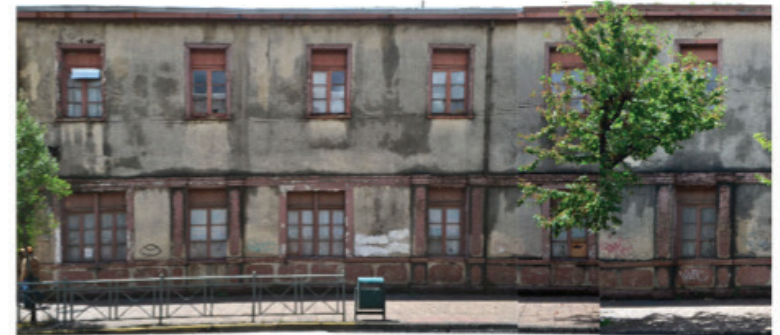
Fachada Poniente (a)
