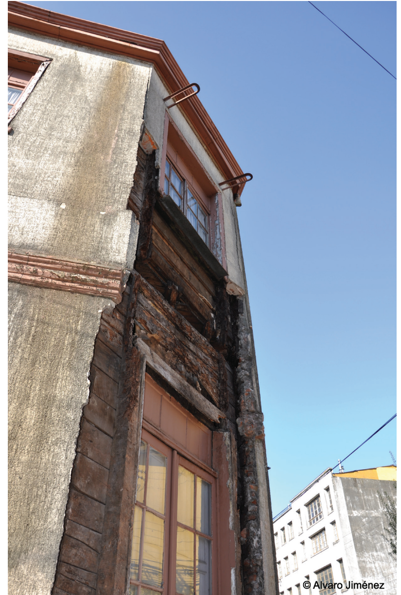
Figura 77: Fotografía detalle daños ochavo tras el terremoto del 27 febrero 2010. Fuente: Álvaro Jimenez
