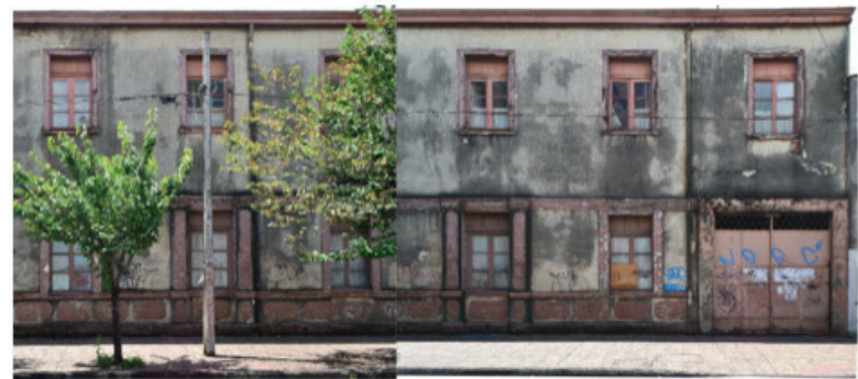
Fachada Poniente (b)
