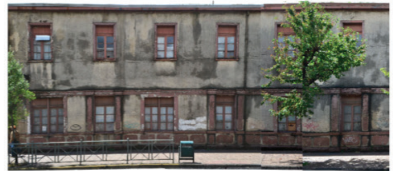
Fachada Poniente (a)
