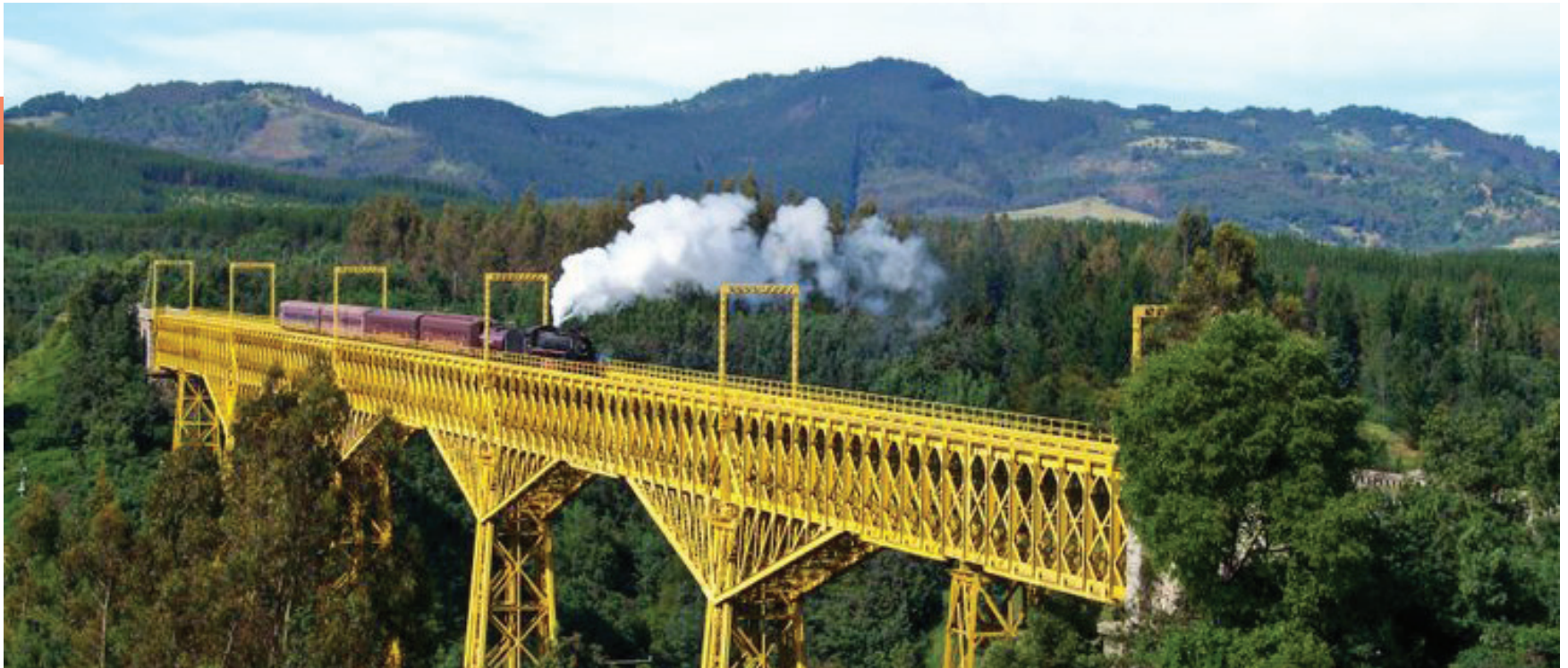
Figura 31: Fotografía Viaducto del Malleco, Collipulli. Fuente: Wikimedia
