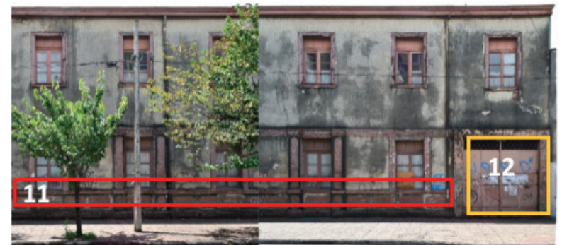
Fachada Poniente (b)
