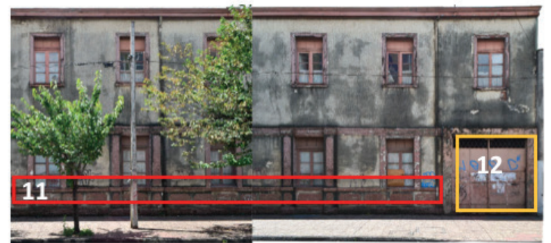
Fachada Poniente (b)
