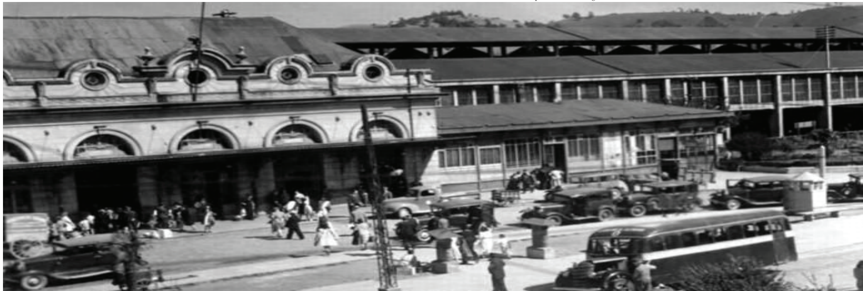
Figura 4: Estación ferroviaria de Temuco. Fuente: Archivo Memoria Chilena. http://www.memoria.cl
