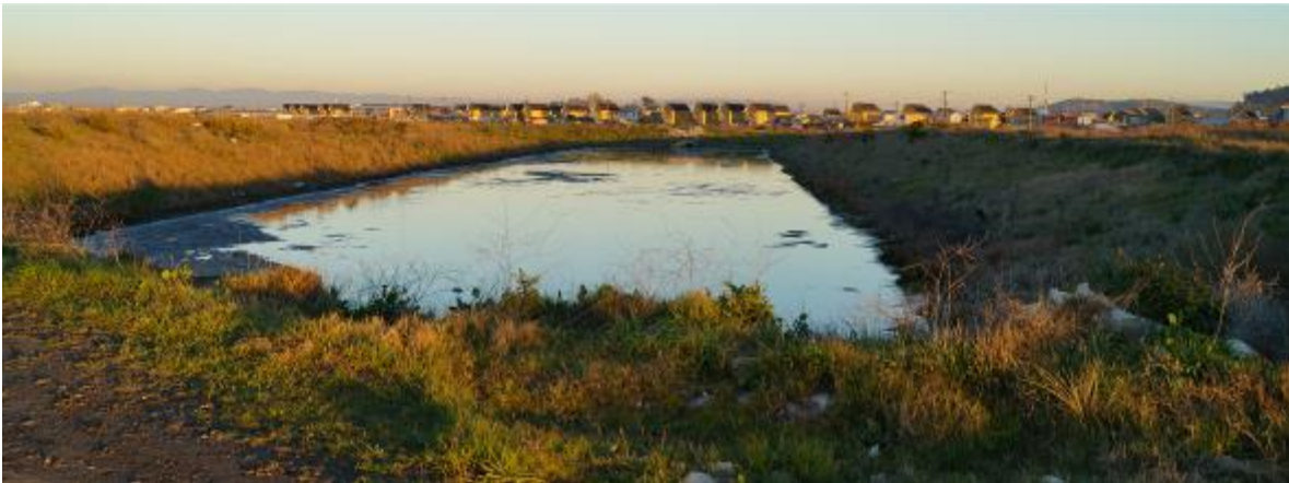
Imagen 69 / Piscinas de retención de aguas lluvias aledañas a la población Santa Clara (al fondo) / Fuente: archivo propio
