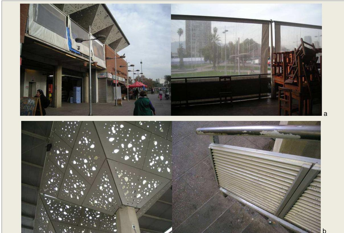
IMAGEN 55: Detalles generales: a) Plásticos para cerrar los balcones en piso 2º; b): Detalle de la perforación en cubierta para luz natural y muestras de algunas evidencias del descascarado de la pintura o signos de oxidación.
