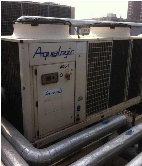
Ilustración 23 Fotografía de Equipo 3, Zona 8.
