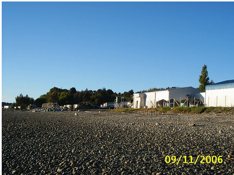
A.6: Instalaciones del centro experimental Quillaipe de Fundación Chile (otro ángulo).
