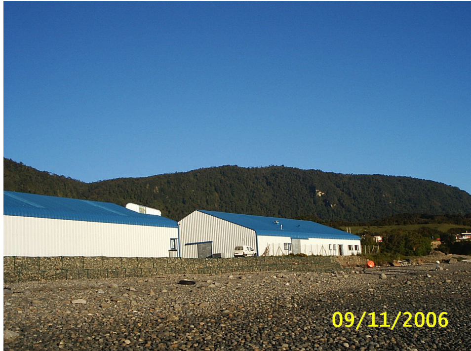
A.5: Instalaciones del centro experimental Quillaipe de Fundación Chile.
