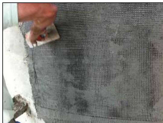
Figura 2.27: Aplicación del recubrimiento final de matriz cementícea sobre la malla
