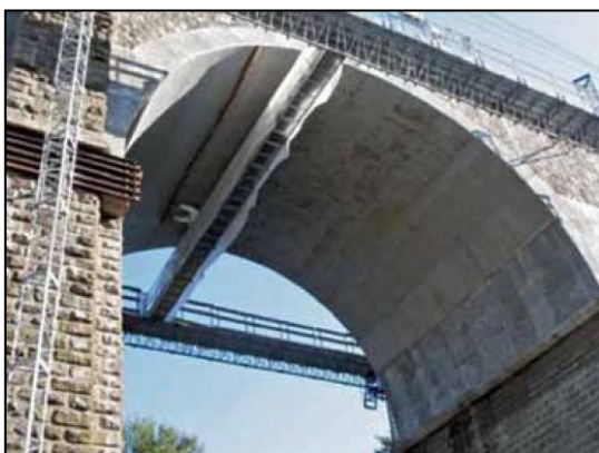
Figura 2.16: Refuerzo del puente ferroviario
