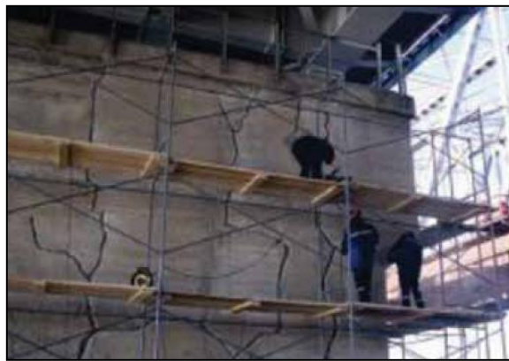
Figura 2.19: Reparación de las grietas previa a la aplicación del sistema FRCM
