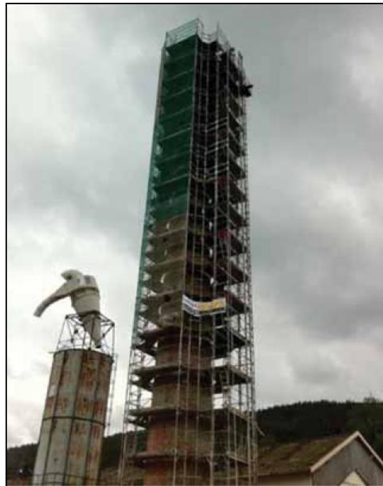
Figura 2.26: Chimenea antes de comenzar la reparación con FRCM
