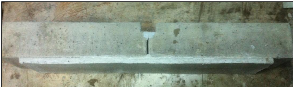
Figura 5.8: Viga antes de la instalación de la rótula de ensayo
