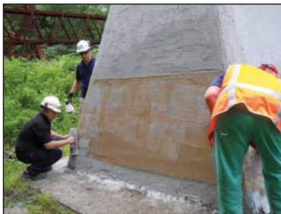
Figura 2.24: Aplicación de la última capa de matriz sobre las mallas de fibras
