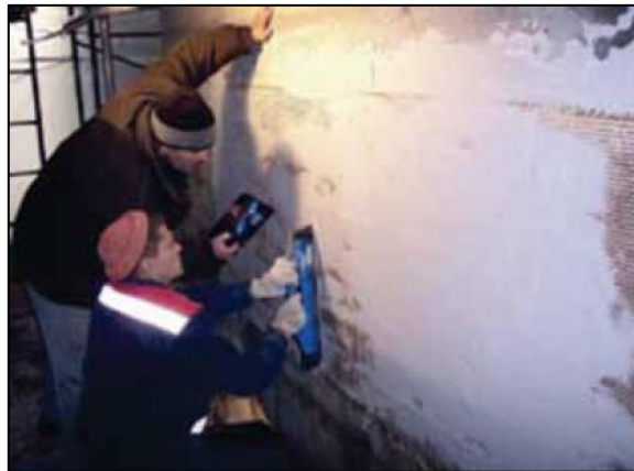
Figura 2.20: Aplicación de la capa de terminación con mortero impermeabilizante
