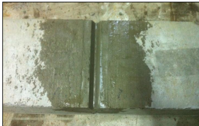
Figura 5.9: Viga después de la instalación de la rótula de ensayo
