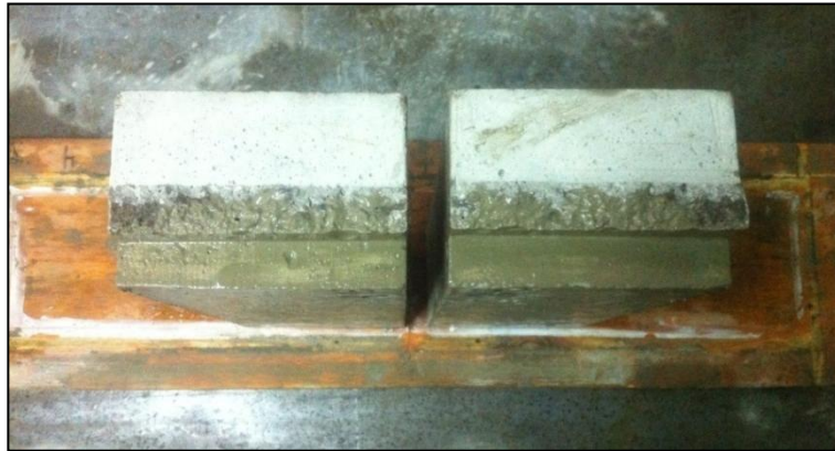
Figura B.10: Superficie de las vigas antes de ser reparadas
