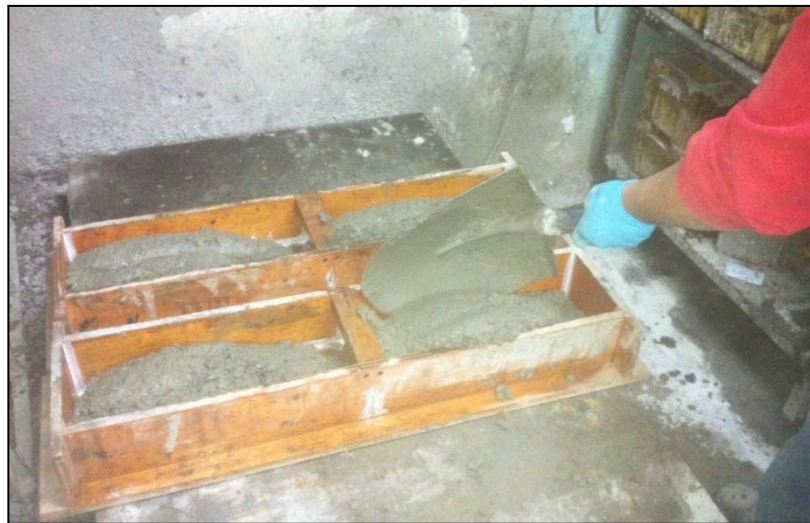
Figura B.6: Llenado de moldes de vigas
