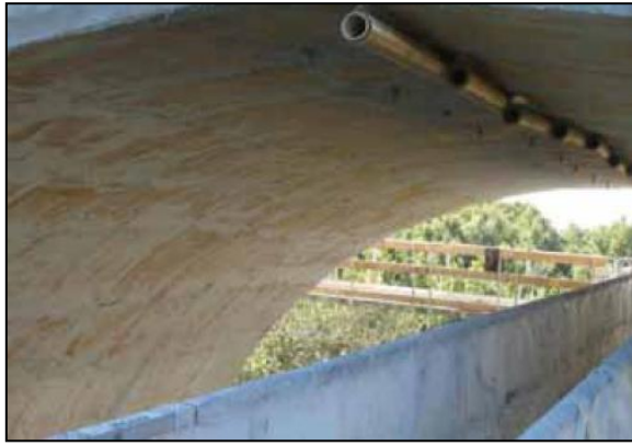
Figura 2.17: Segunda capa de fibra aplicada
