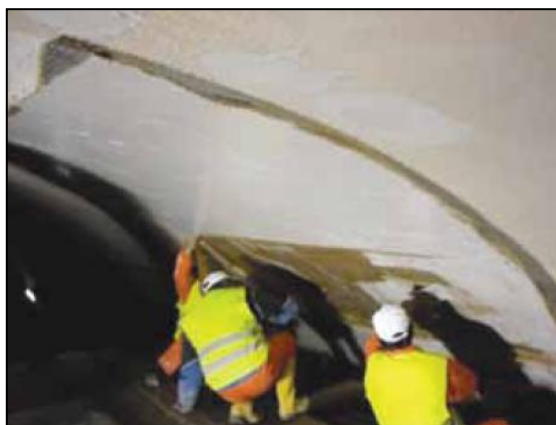
Figura 2.25: Aplicación del recubrimiento final de matriz cementícea
