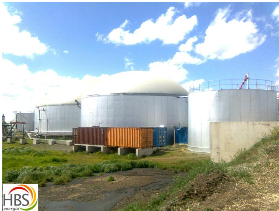
Ilustración Nro. 5: Estanque de acumulación de agua caliente, los dos fermentadores y estanques de hidrólisis (de izquierda a derecha).
