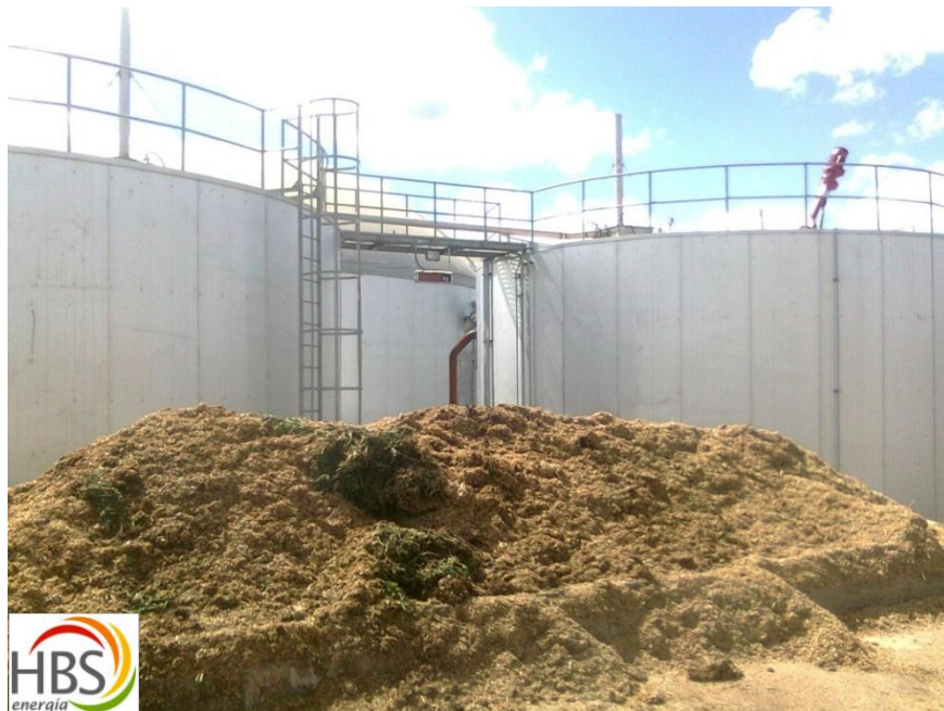
Ilustración Nro. 3: Residuos de cosecha y estanques de hidrólisis.
