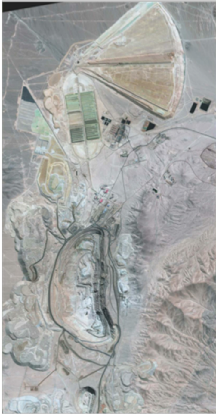
Ilustración 1 Vista en planta Mina Radomiro Tomic
