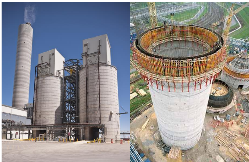
Ilustración 3: Silos de hormigón armado, México y USA.
