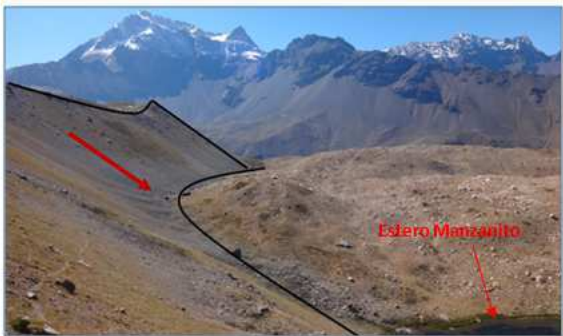
Figura 26: Deslizamientos al interior del depósito en la zona del estero Manzanito (borde del deslizamiento en rojo, la flecha indica dirección de movimiento).
