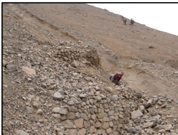
Figura 21: Detalle de obras de mampostería en el extremo sur (curva de retorno) de las Franjas 6 y 7 del Segmento 1. Se observan los muros de retención cortados por el aluvión y parcialmente cubiertos por rodados.
