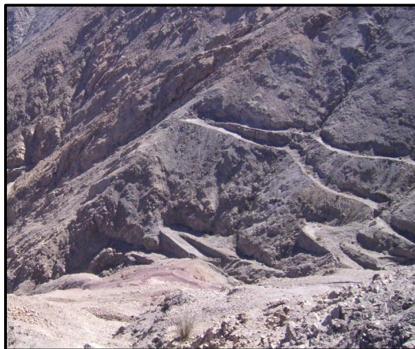
Figura 30: Detalle de sector con terraplenes hacia el extremo inferior del Segmento 3.
