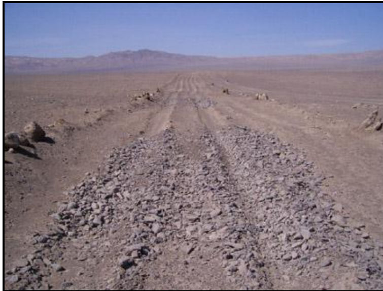
Figura 19: Vista general: Detalle de señalizaciones laterales y relleno del camino.
