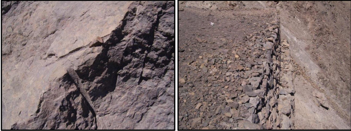
Figuras 28 y 29: Detalle de negativos de corte con barreno en la ladera activa la curva de retorno entre las Franjas 2 y 3 (izquierda) y de muro de contención tipo banquina que forma la curva de retorno entre estas franjas del Segmento 3.
