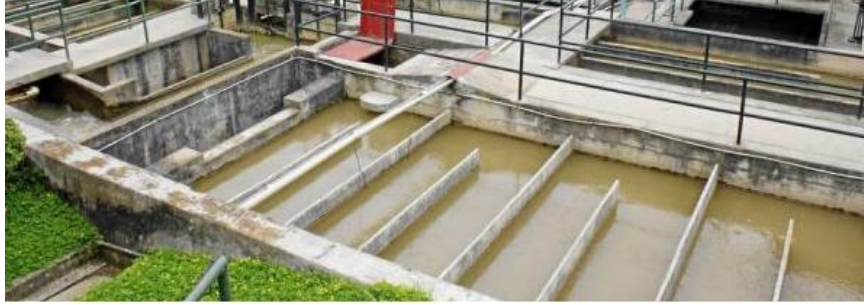
Figura 2-1: Floculador hidráulico horizontal.
