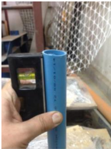
Figura 3.12: Nivelación de los tubos de pvc
