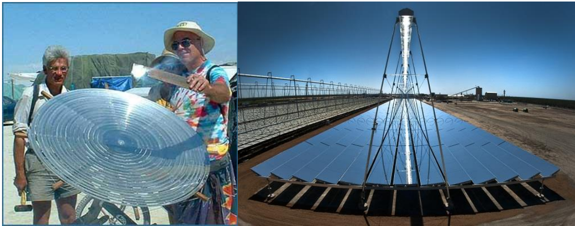
Figura 3. 26 (Izquierda) Hombres encendiendo una antorcha con un espejo Fresnel parabólico. 1997 (Derecha) Colector solar a base de espejos Fresnel Lineales, AREVA. [35][36]
