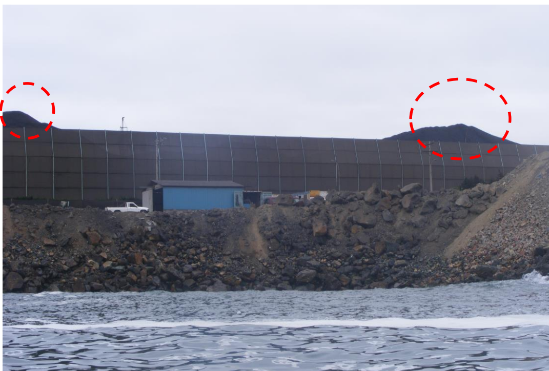
Figura 21: Mallas de contención fuera de norma por parte de Eléctrica Guacolda, se observa que resaltan montículos de carboncillo en los sectores de acopio.
