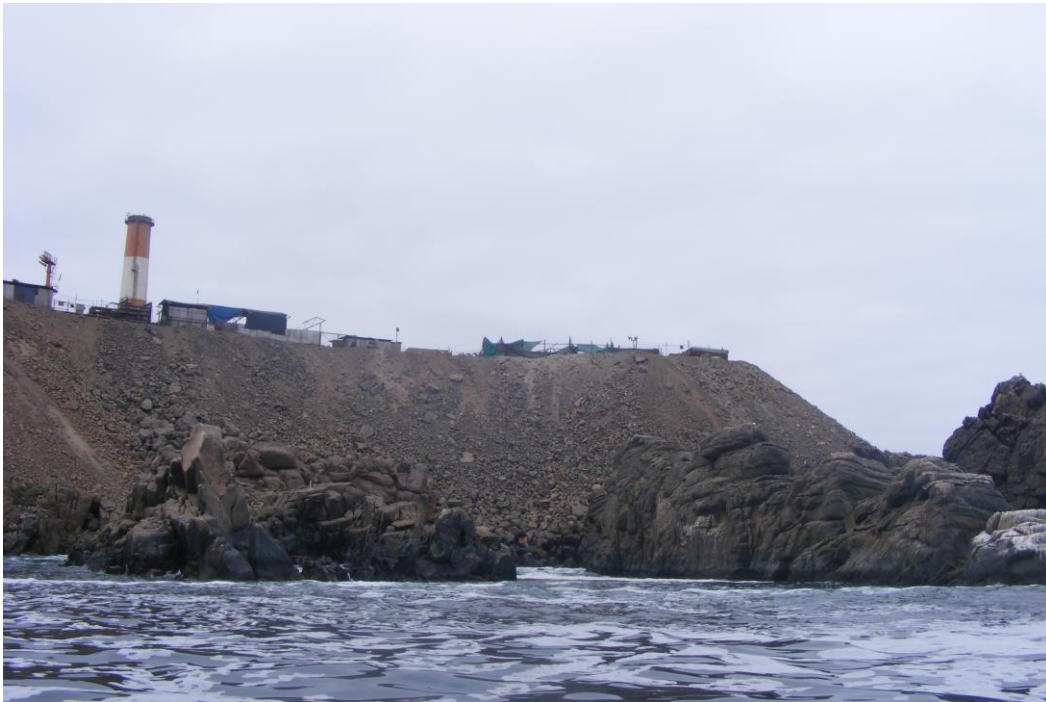
Figura 10: Escombros que componen la unión entre continente e isla Guacolda
