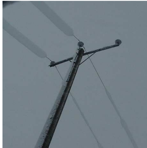
Ilustración 2.9: Aumento de sección transversal del conductor por acumulación de nieve.
