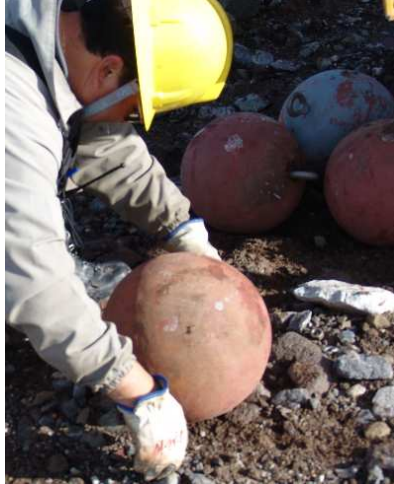
Ilustración 2.15: Contrapesos en las líneas para prevenir ice jumping.
