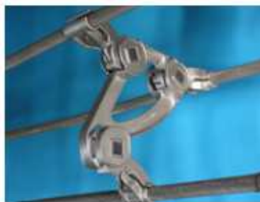
Ilustración 2.5: Separador amortiguador para tres conductores por fase.
