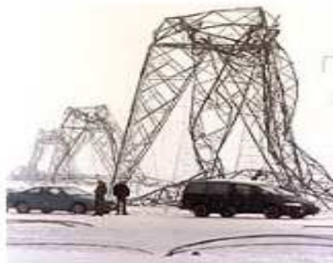
Ilustración 2.11: Daño a varias torres de alta tensión por efecto galloping [3].
