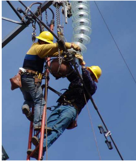
Ilustración 2.16: Instalación de contrapesos en división El Teniente.
