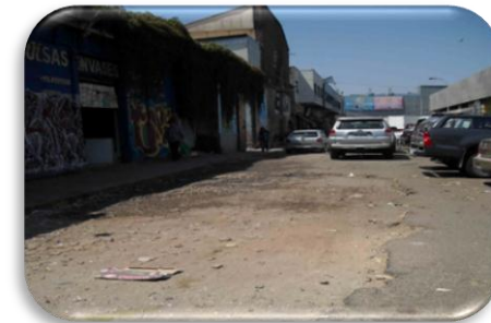
Calle deteriorada Antonio López de Bello
