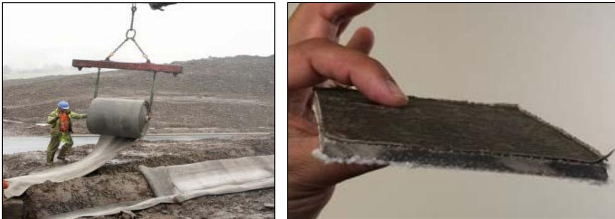
Figura 3.5. Instalación manta de hormigón y muestra del resultado [23].
