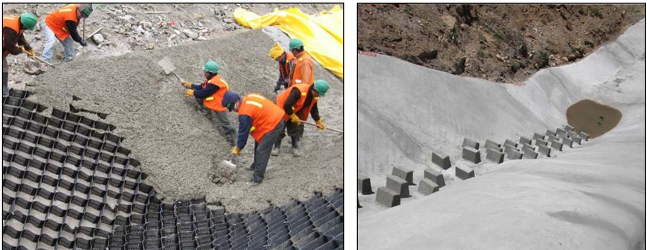
Figura 3.4. Construcción de canal de aducción y dissipador de energía con Geoweb.
