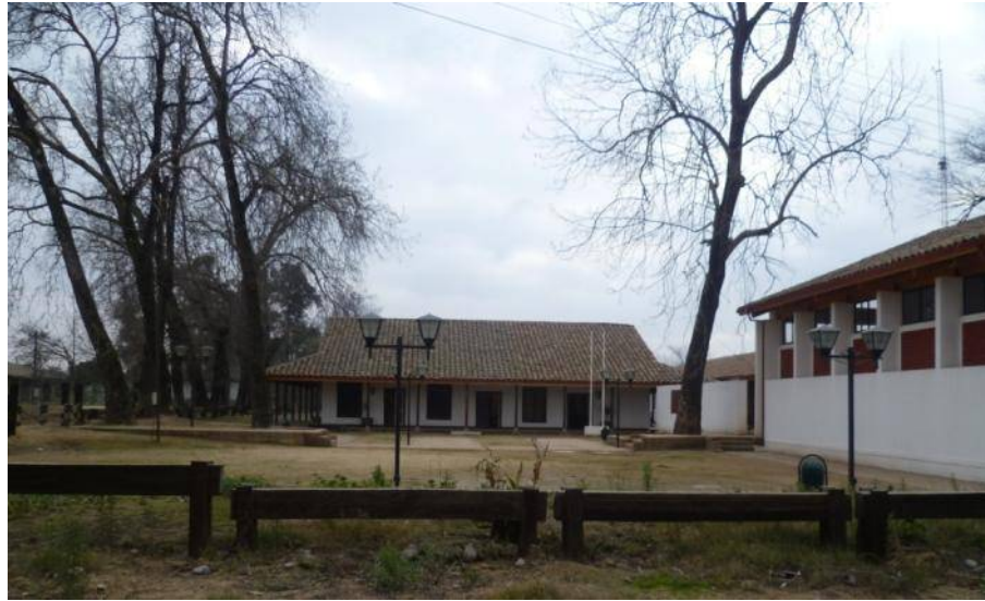
Figura 57: Fotografía del cuartel de bomberos reconstruido. Fuente: Archivo propio.
