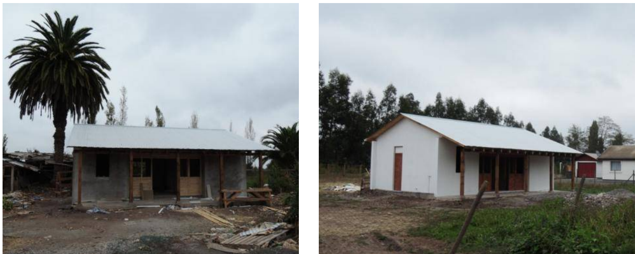
Figura 70: Fotografía de la casa "Módulo Base" en construcción. Fuente: Archivo propio.
