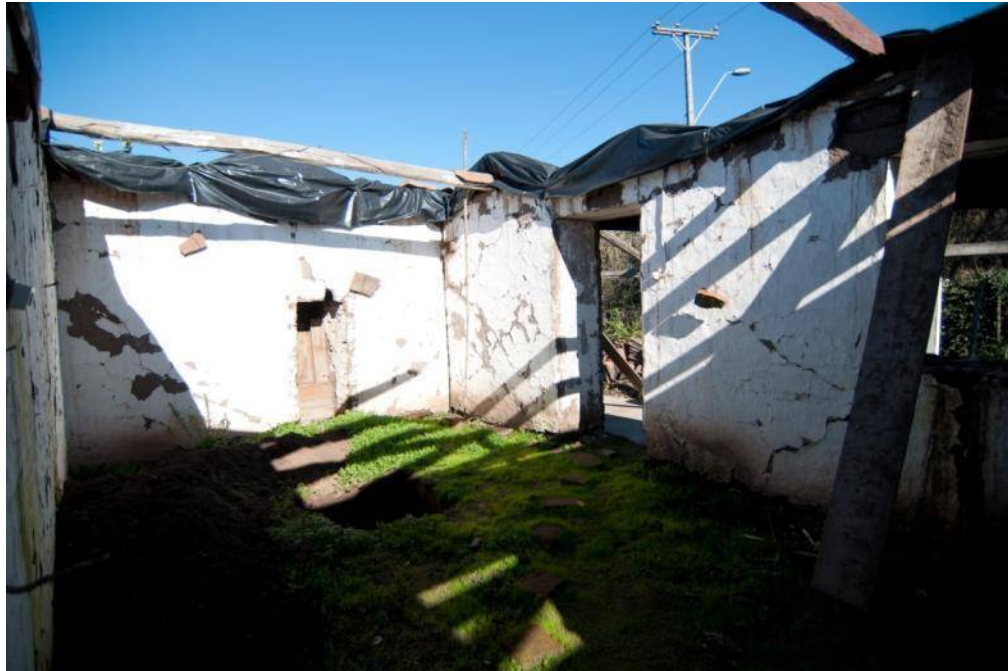
Figura 51: Fotografía de recinto interior de una de las casas de entrevistados con motivo de esta investigación. Fue tomada con posterioridad al terremoto de 2010 y antes de que se realizara su reconstrucción.
