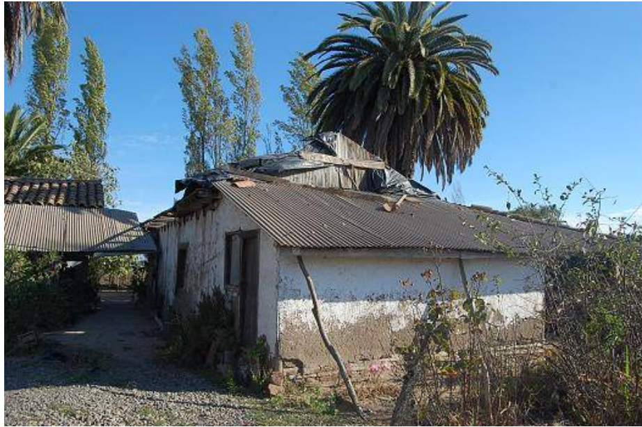
Figura 66: Fotografía post terremoto de 2010 mostrando daños acumulados en una de las casas de antiguos inquilinos de la Hacienda San José del Carmen, El Huique. Fuente: Archivo propio.
