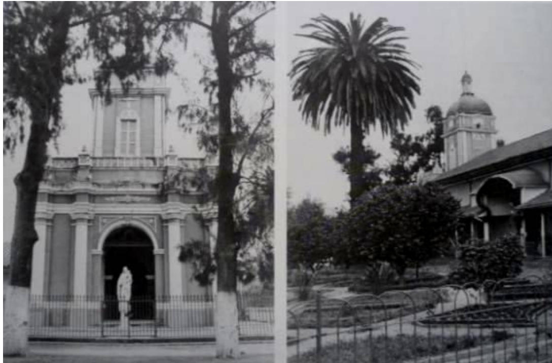
Figura 16: Fotografías de la Iglesia de San José del Carmen, El Huique. Fuente: Guarda, G. (1988). Arquitectura Tradicional de Colchagua .
