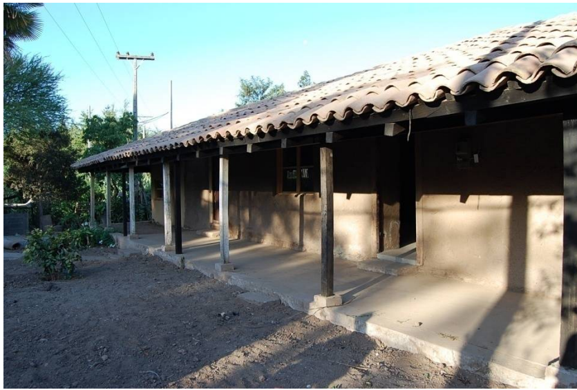
Figura 29: Fotografía post reconstrucción de la casa de uno de los habitantes de El Huique, entrevistados con motivo de esta investigación. Fuente: Elaboración propia.
