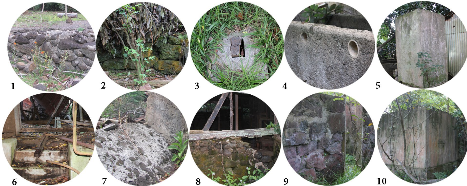
Fig. 72. Fotografías de los elementos a mantener y consolidar del galpón. Fuente: Propia.
