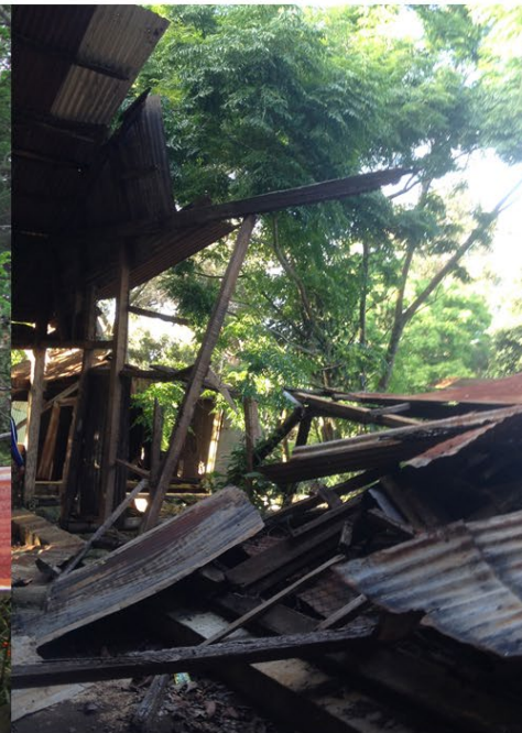
4. Galpón de acopio
