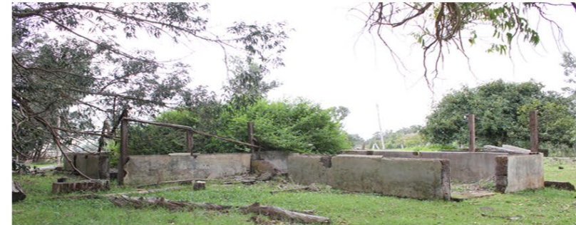
1.2 Sala de químicos
