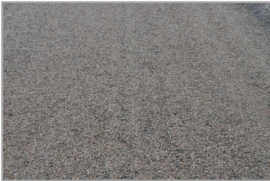
Fig. 5.6. Aplicación de Sello Sincrónico DTS recién ejecutado.
