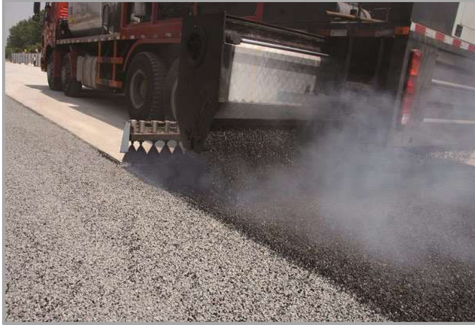
Fig. 5.5. Aplicación de Sello Sincrónico. Bitumen y agregado se aplican simultáneamente.
