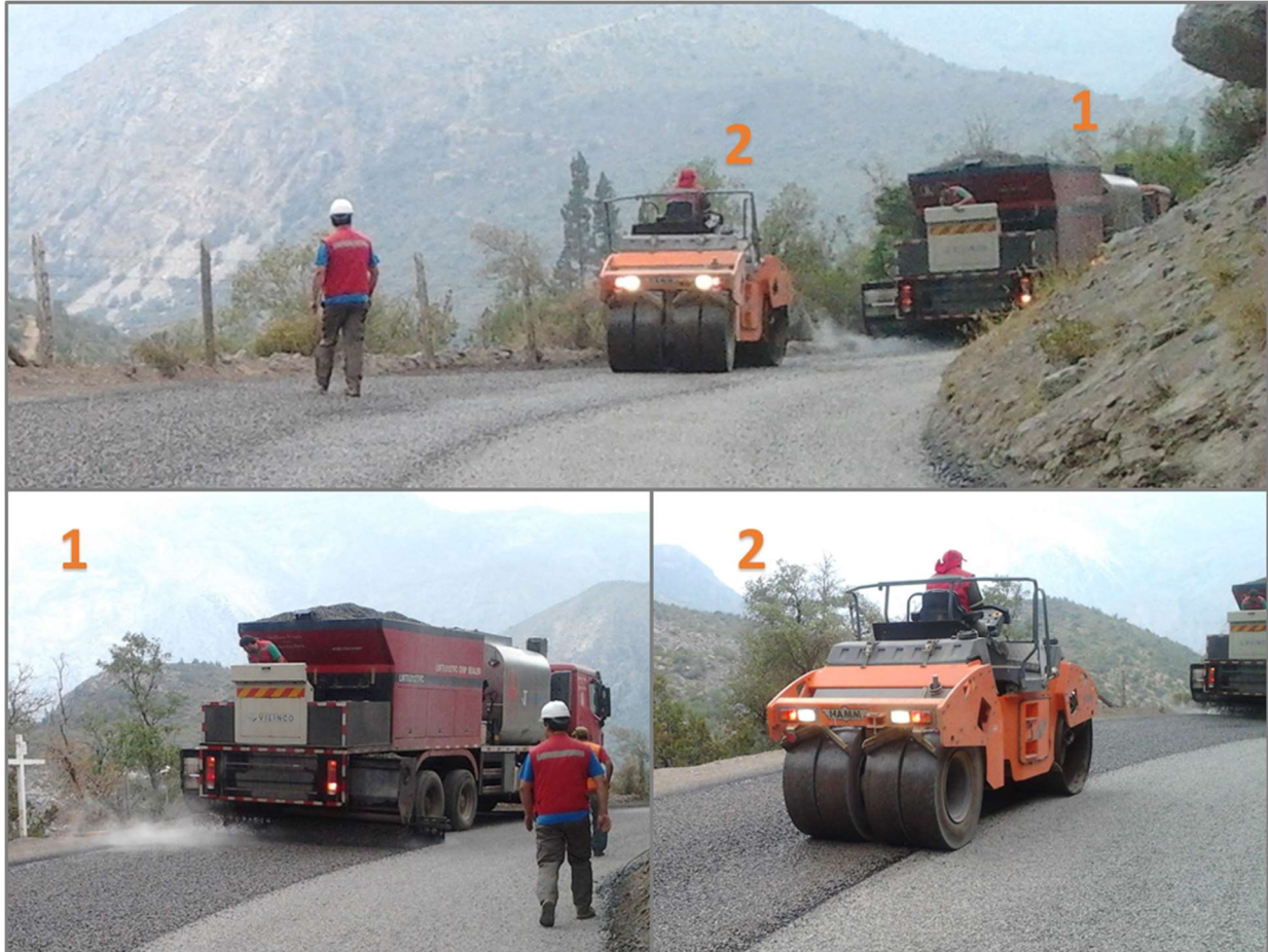
Fig. 5.3. Equipos empleados en Tratamiento Superficial con sistema sincrónico.
