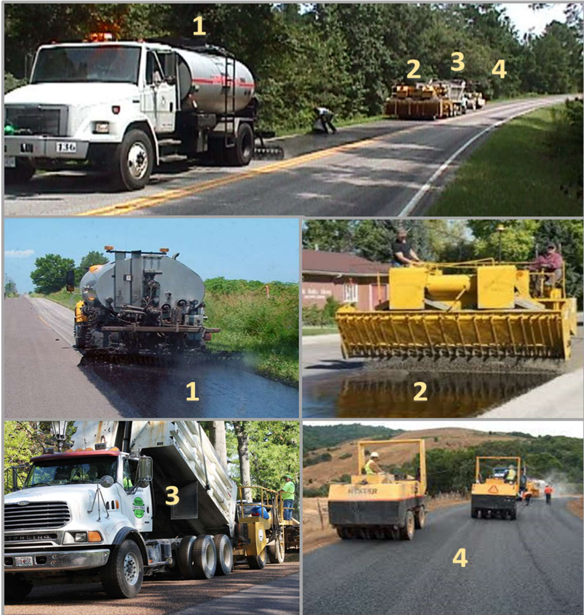
Fig. 5.2. Equipos empleados en Tratamiento Superficial con sistema tradicional.
