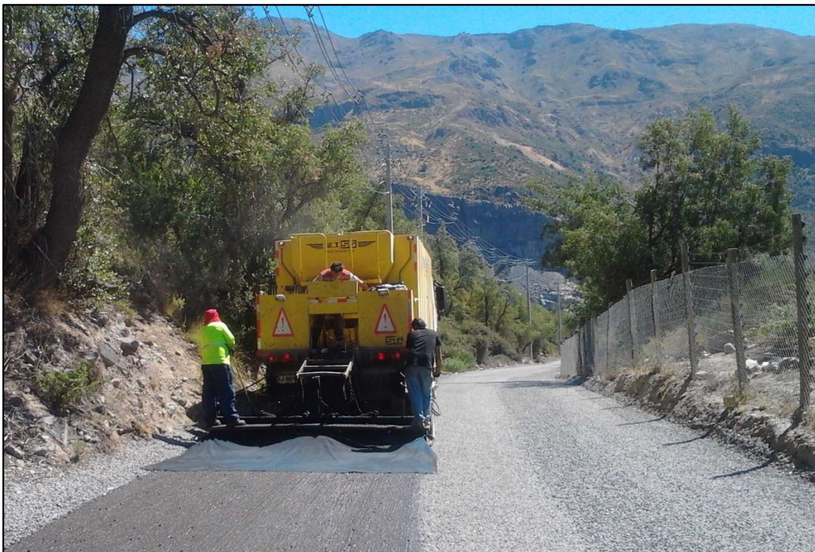
Figura 4.1.- Aplicación de Cape Seal, TSS + Lechada Asf. (Ruta G-465 Las Melosas, Chile – Feb 2014).
