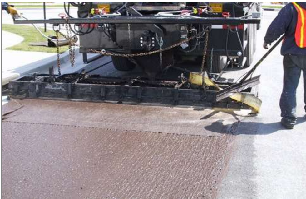
Fig. 4.5.- Aplicación de Lechada Asfáltica.
