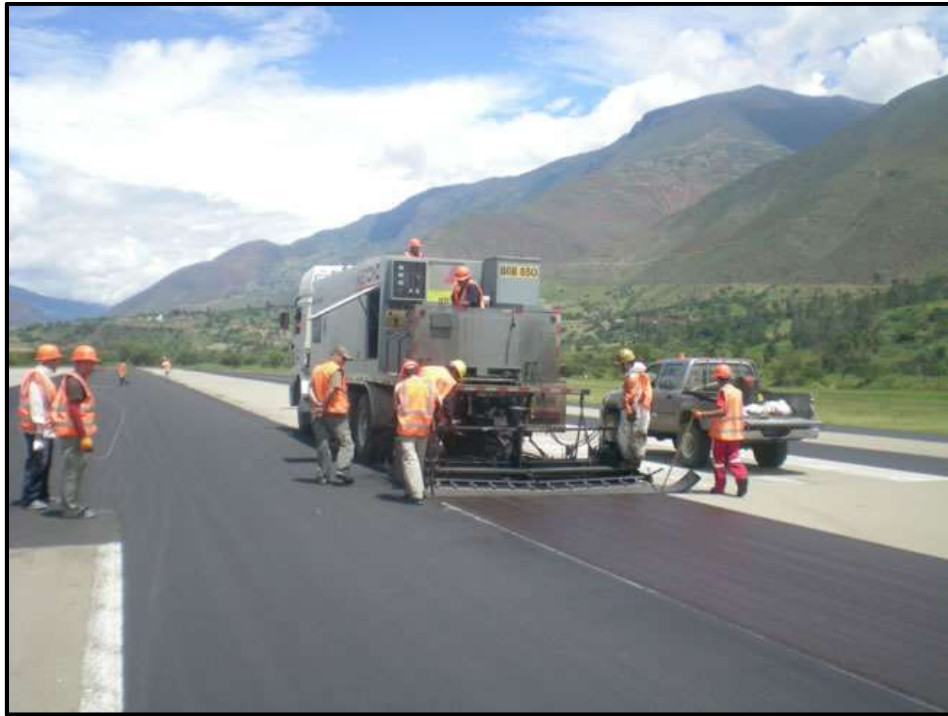
Figura 3.6.- Aplicación de Microaglomerado tipo Slurry (China 2011).
