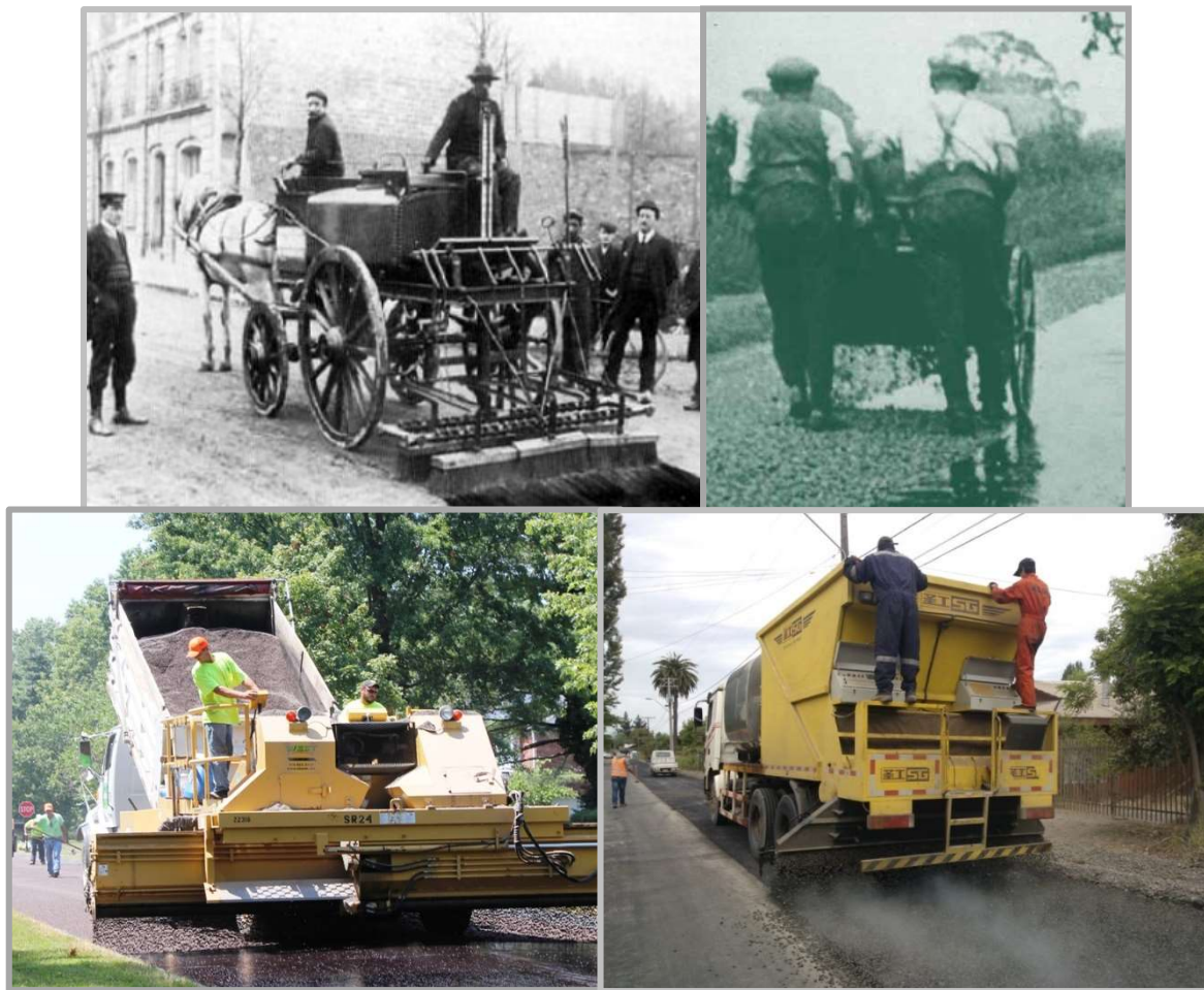
Fig. 2.1.- Arriba, la técnica de Tratamiento Superficial hacia 1890. Abajo a la izquierda el proceso de TS actual tradicional, a la derecha el nuevo proceso de TS sincrónico.
