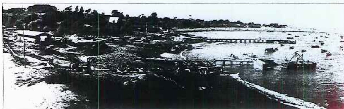
Fig. 5. Playa central de Puerto Sur con faenas de construcción de rampa, Enero del 2001
