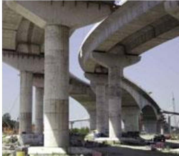
Figura II-4. Columnas y fundaciones del James River Bridge que corresponden a hormigones masivos (Cement.org, 2015).
