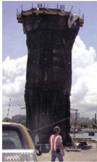
Figura II-6. Mantas de aislación sobre una columna de concreto (Cement.org, 2015).
