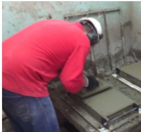
Figura III-10. Platachado posterior al vibrado de la loseta.
