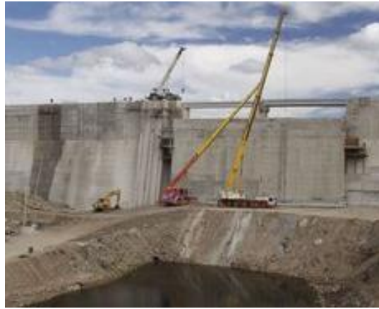
Figura 1-2: Hormigón Masivo (Idiem uchile.cl, 2015) [2]
